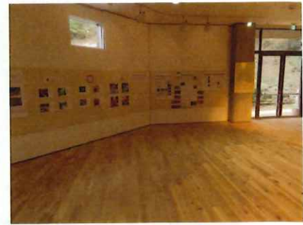
R3 フローリング施工箇所
